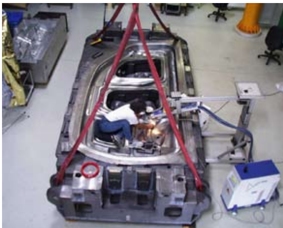
Reparaturarbeiten an einem tonnenschweren Formwerkzeug bei der DSI Laser Service GmbH
